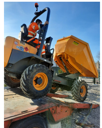
Déchargement mini dumper
